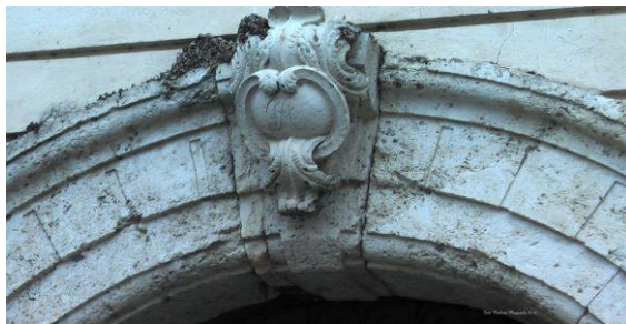
Particolare del portale con inciso l'anno di costruzione (1864)
